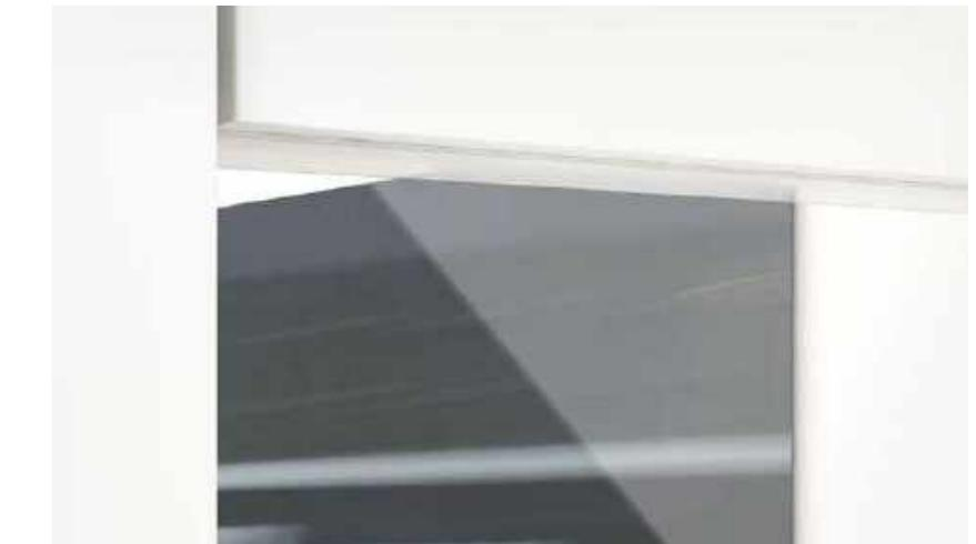
▲ Übergänge zwischen Glas und Holz durch Dichtlippe abgeschlossen
