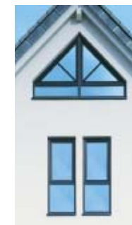
Les petits-bois intermédiaires amplifient les lignes horizontales et confèrent aux fenêtres un aspect plus large.
