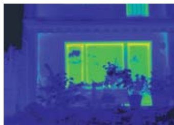
A la suite d'une intégration soignée de fenêtres Systèmes Corona CT 70 Rondo, la thermographie infrarouge démontre combien l'investissement est profitable sur le plan énergétique. Les déperditions d'énergie deviennent pratiquement nulles.
